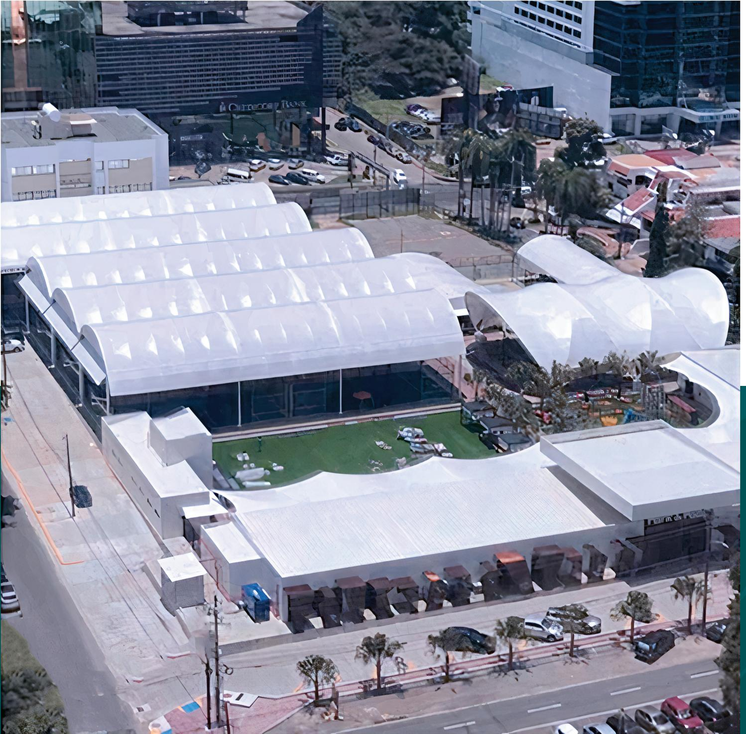
Una de las características más notables de las tensoestructuras es su flexibilidad en el diseño. La combinación de cables tensados y membranas permite la creación de formas curvas, fluidas y sorprendentes que pueden ser adaptadas para encajar en cualquier espacio. Esto da lugar a arquitectura orgánica que se integra armoniosamente con su entorno, rompiendo con la rigidez de las estructuras convencionales.
