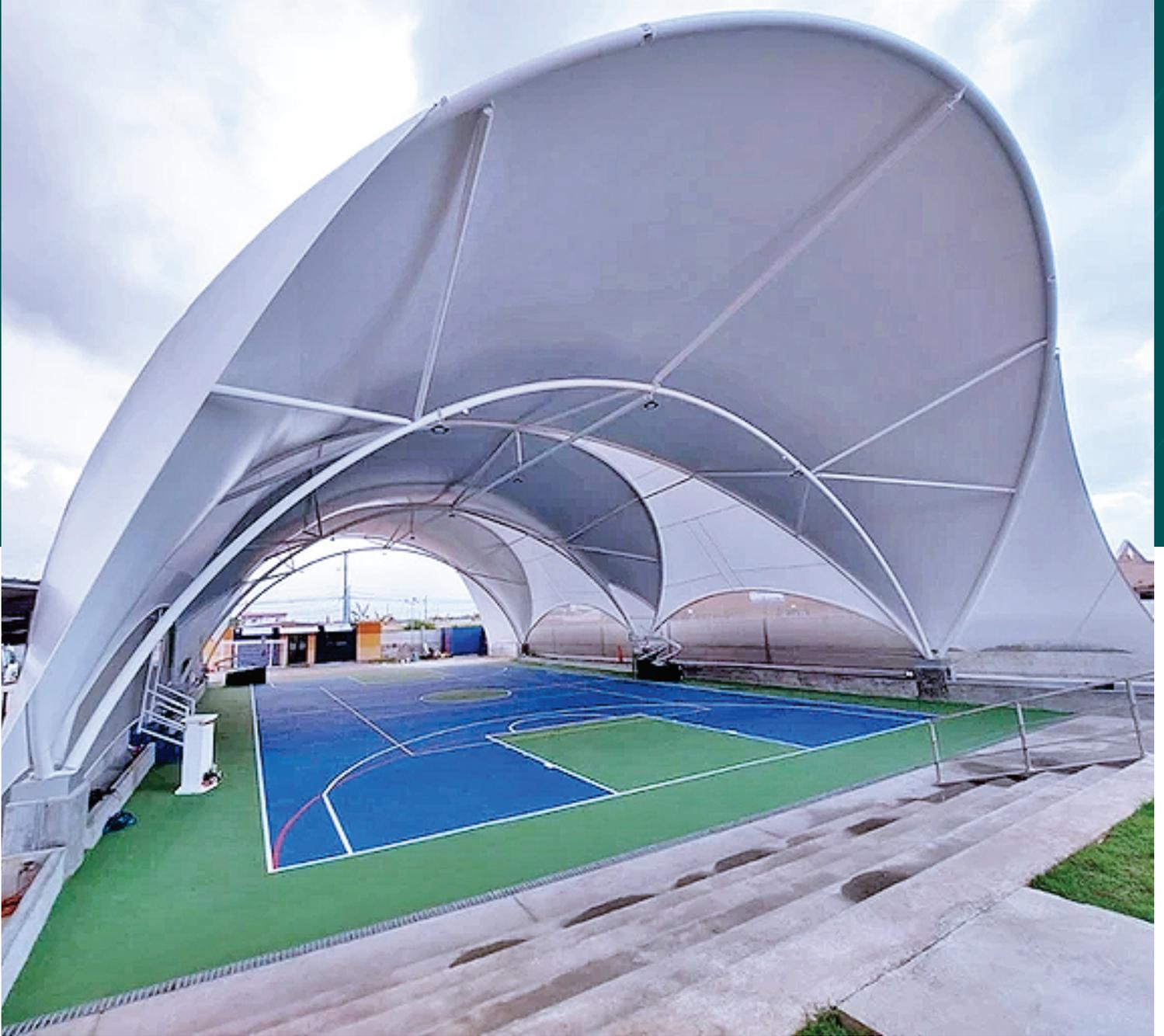
Están formados por tejidos pre-tensados y redes de cables que se sustentan a base de elementos rígidos tipo mástiles, responden a la actuación de las cargas desarrollando únicamente esfuerzos de tracción, por lo que constituyen una estructura bastante resistente pero ligera. Según la magnitud y dirección de las fuerzas se generan fuerzas únicas y curvaturas en más de un eje al mismo tiempo, obteniendo formas resistentes y de alto valor estético.
